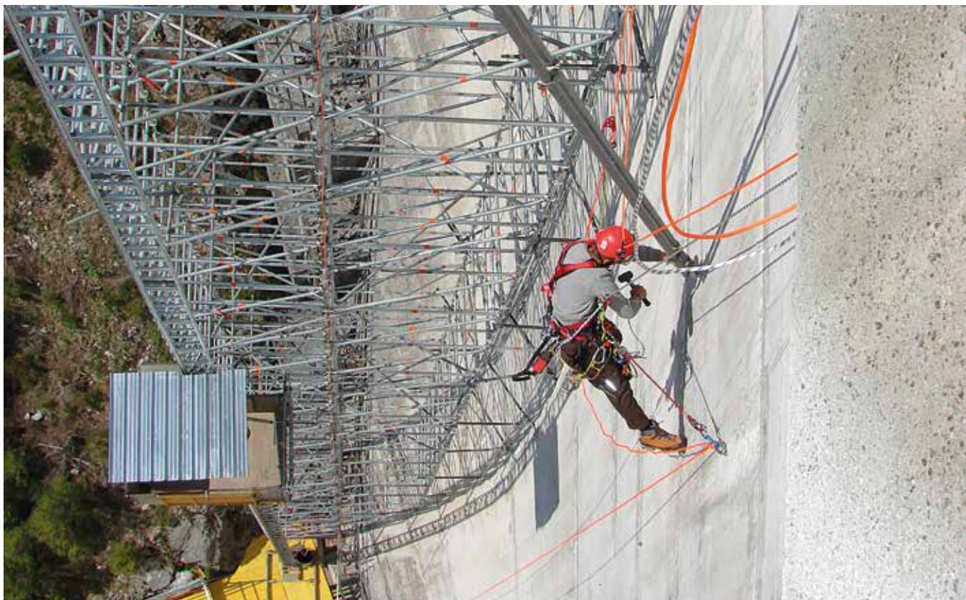
Installazione di ponteggi sulla diga di Hongrin. Installation d'un échafaudage sur le barrage d'Hongrin. Aufbau von Baugerüsten am Staudamm von Hongrin. Vaud, Switzerland (courtesy of Corde-Access SA).
