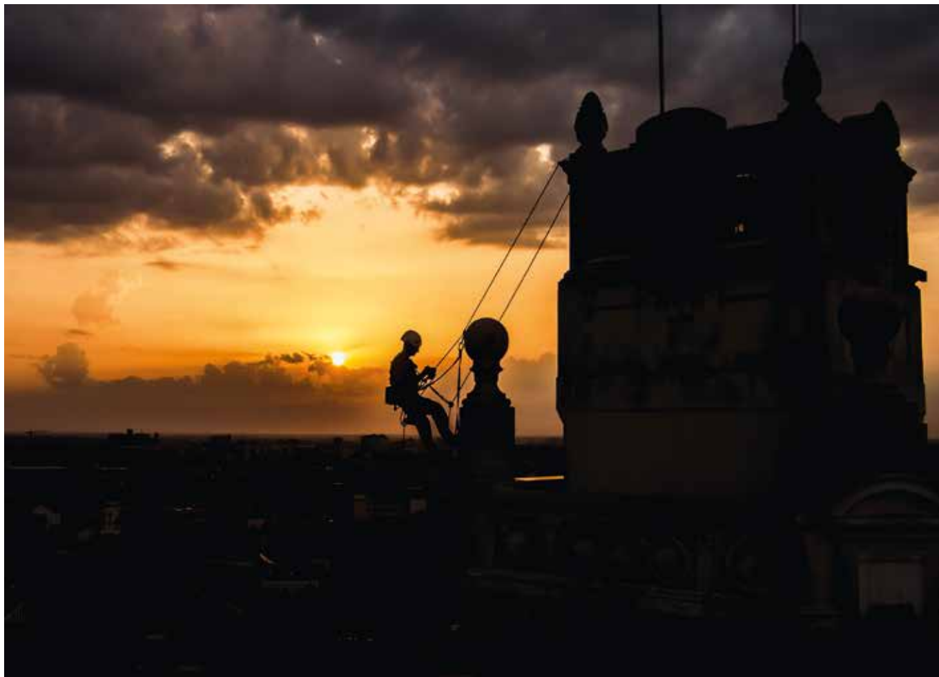
Lavori di accesso su corda sulla torre comunale di Oradea. Travaux d'accès sur corde sur la tour municipale d'Oradea. Seilunterstützter Zugang am Stadtturm von Oradea. Oradea, Romania (courtesy of Camp Technical Solutions, ph. Amazing Visuals Studio).
