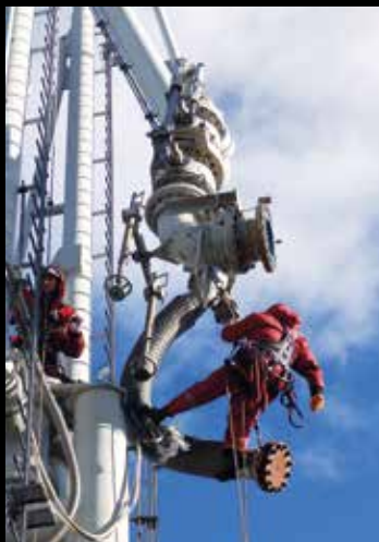
Manutenzione di tubi di rifornimento portuali. Maintenance de conduits portuaires. Wartungsarbeiten an Standrohren im Hafen. Harbor of Sillamäe, Estonia (courtesy of Extreme Works OÜ, ph. Artem Krasnenko).
