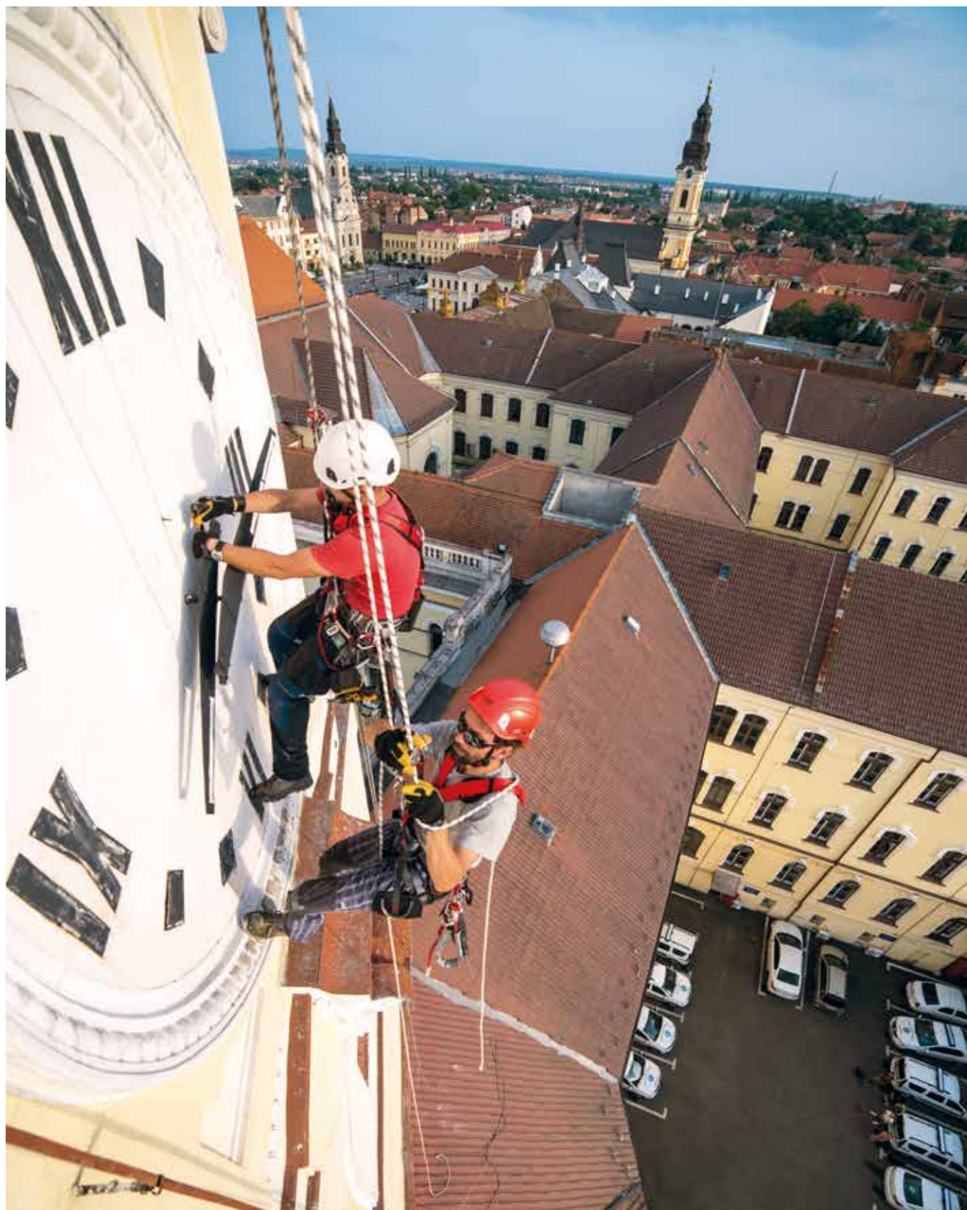
Lavori di accesso su corda sulla torre comunale di Oradea. Travaux d'accès sur corde sur la tour municipale d'Oradea. Seilunterstützter Zugang am Stadtturm von Oradea. Oradea, Romania (courtesy of Camp Technical Solutions, ph. Riky Felderer).
