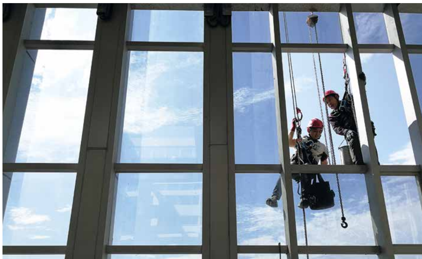
Installazione dei vetri su di un grattacielo. Installation de vitres sur un gratte-ciel. Glasinstallation an einem Wolkenkratzer.
