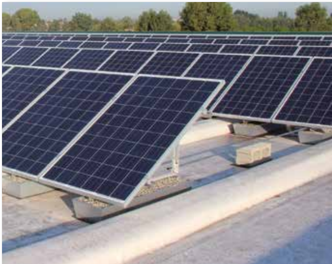
Pannello singolo verticale a 30° con vasche zavorra.
