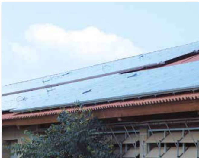
Tetto a falda-recupero amianto. Applicazione con vitoni da legno FVT1315.
