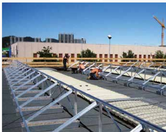
Tetto piano industriale con guaina. Applicazione con vasche zavorra FVT1455 e triangoli a 30° FVT1511.
