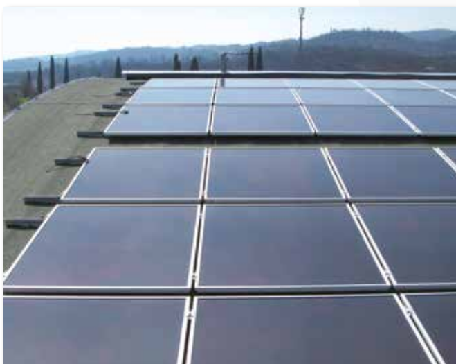
Tetto guaina industriale a volta. Applicazione diretta PRF Zincato a Caldo con guarnizione butilica.
