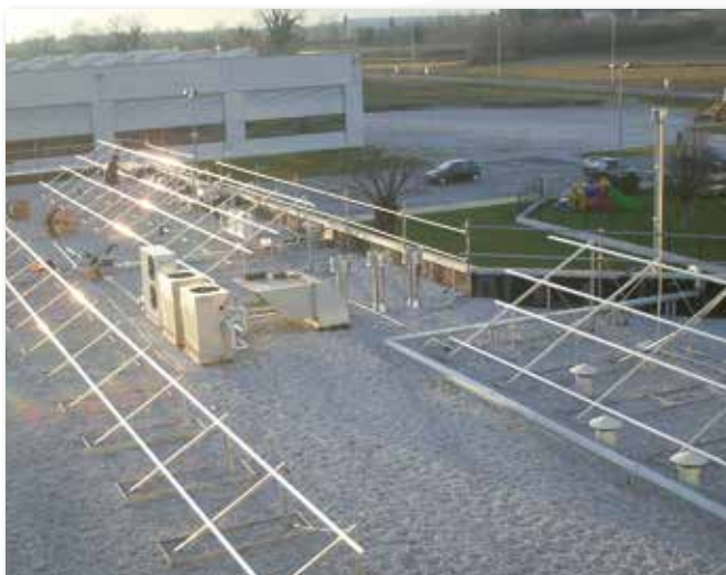
Tetto piano industriale con ghiaia. Applicazione con vasche zavorra FVT1455 e triangoli a 30° FVT1511.
