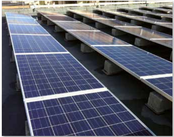
Pannello orizzontale e zavorre Flat.
