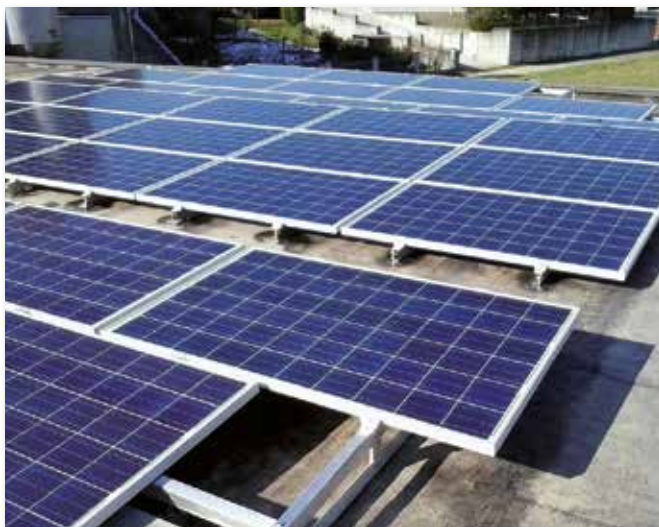
Triangolo triplo orizzontale zavorrato.
