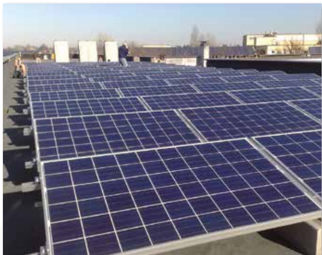
Tetto piano con triangolo singolo verticale zavorrato.
