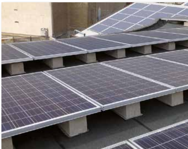
Pannello verticale e zavorre Flat.
