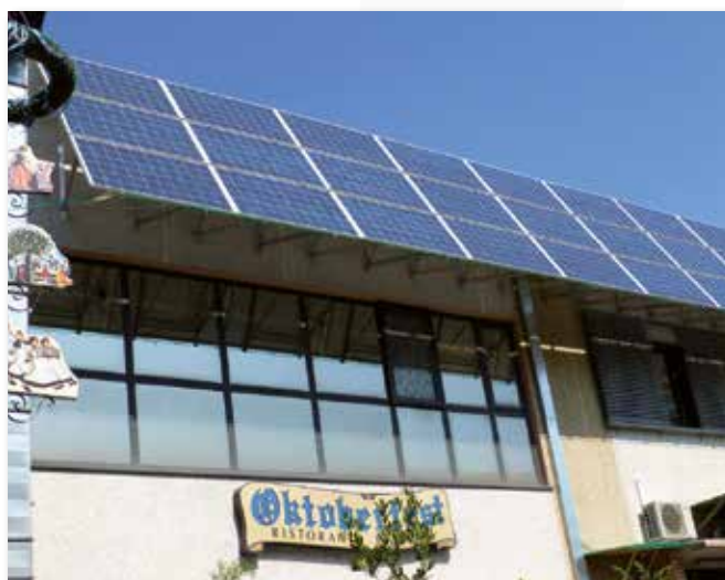
Pensilina con pannello triplo orizzontale.
