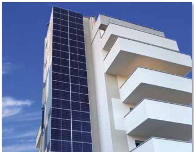
Pannelli in orizzontale in facciata.
