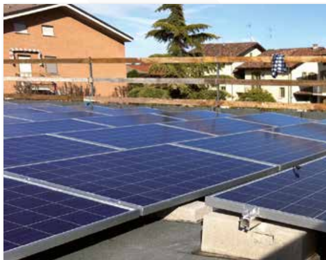
Tetto piano pannello orizzontale e zavorre flat.
