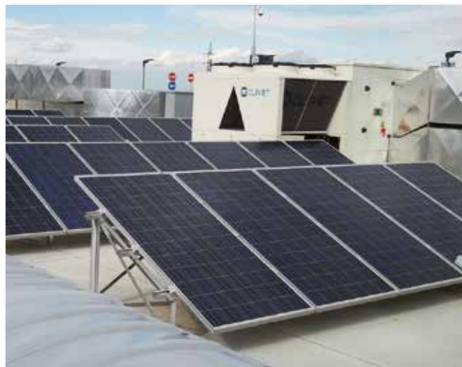
Triangolo singolo verticale 30°.
