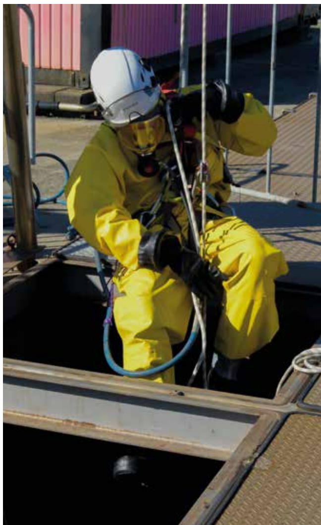
Riparazione di una tubazione in un impianto di depurazione di acque reflue. Réparation d'une tuyauterie dans une station d'épuration des eaux usées. Reparatur eines Rohres in einer Kläranlage. Monthey, Switzerland (courtesy of Corde-Access SA, ph. Corde-Access SA).
