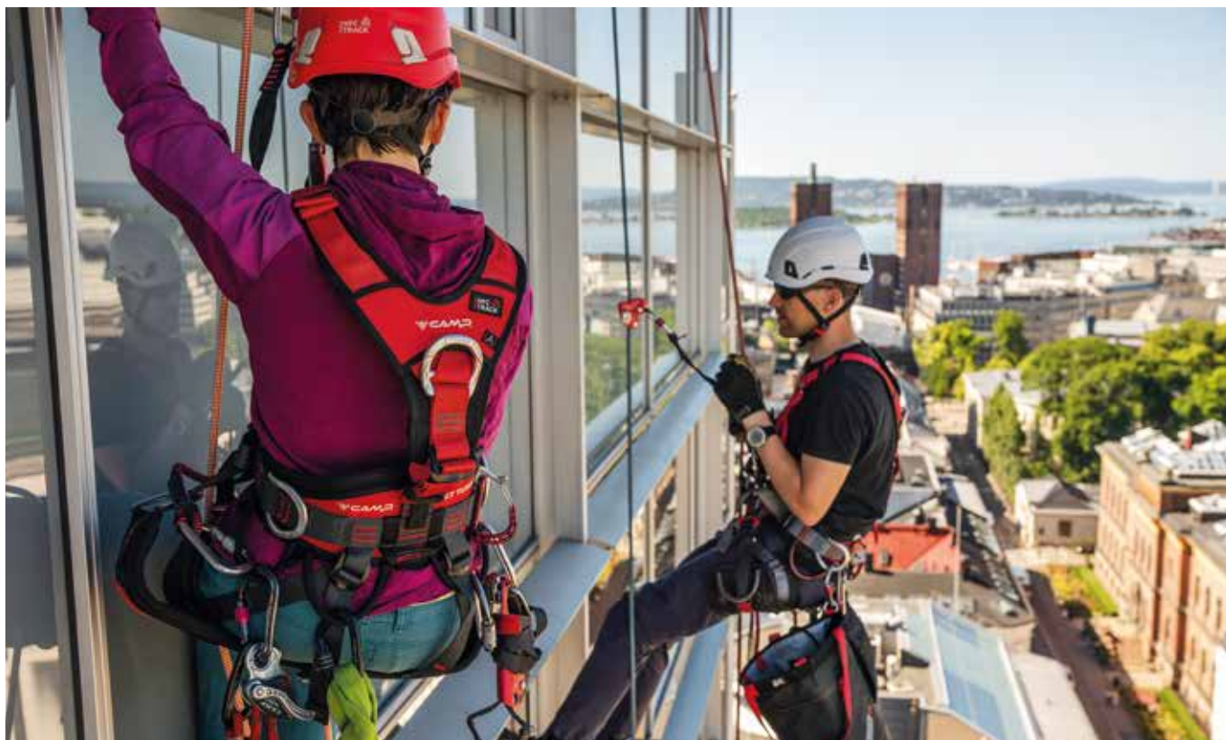
Philippa Betts e Torbjørn Solheim effettuano lavori di manutenzione in accesso su corda sulla facciata di un palazzo. Philippa Betts et Torbjørn Solheim réalisent en accès sur corde des travaux d'entretien en façade d'immeuble. Philippa Betts und Torbjørn Solheim bei seilunterstützten Wartungsarbeiten an einer Gebäudefassade. Universitetsgata 2, Oslo, Norway (courtesy of Varri AS, ph.Kyrre Buxrud).
