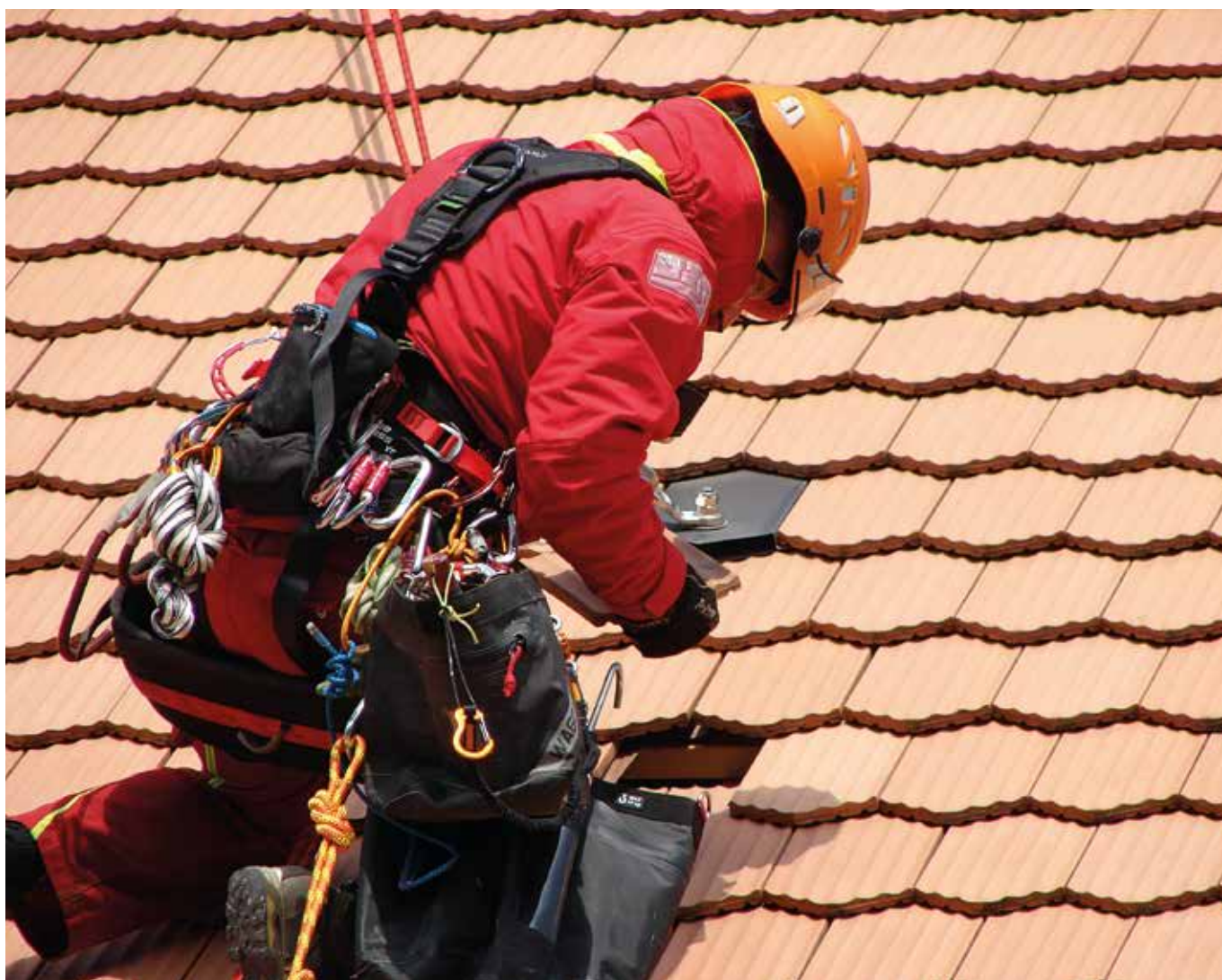
Lavori sul tetto del parlamento del canton Vaud. Travaux sur la toiture du Parlement vaudois. Arbeiten am Dach des Parlaments des Kantons Waadt. Lausanne, Switzerland (courtesy of Corde-Access SA, rigger Andrea Giuzzi, ph. Corde-Access SA).
